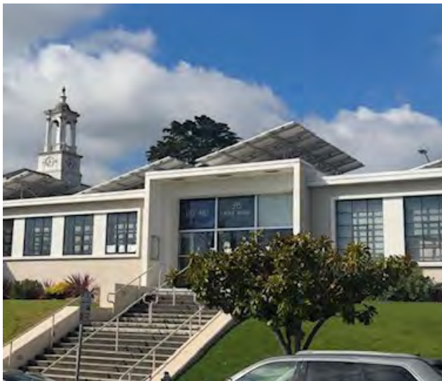
Annex Building of City Hall / Edificio Anexo del Ayuntamiento
