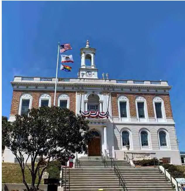
South San Francisco City Hall / Ayuntamiento del sur de San Francisco
