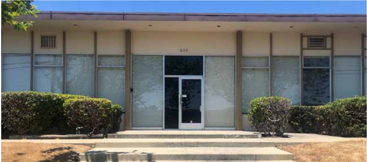
Fig.10 – 439 Eccles Ave. - Front entry way
